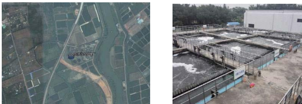
图 4.2-2 东郊污水处理图片
