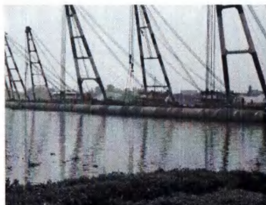
广州西江引水工程
