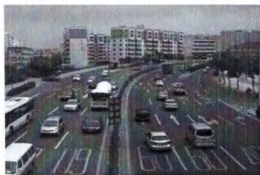
完成后现场照片
