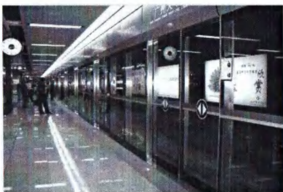
广州地铁二号线屏蔽门系统、扶梯安装工程
